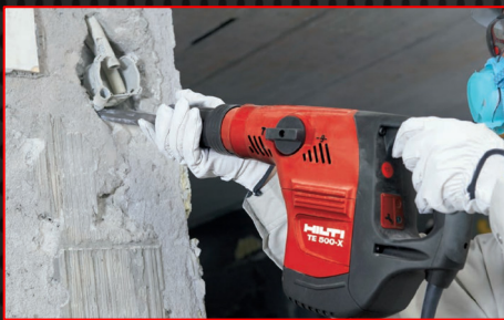
細部のコンクリートハツリ作業に
