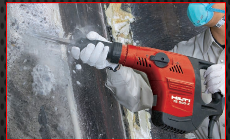
開口、貫通工事に
